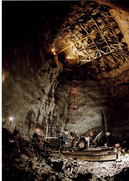
**Annexe figure 1.** L'équipe de construction pose des explosifs pour créer la cavité de l'ONS
